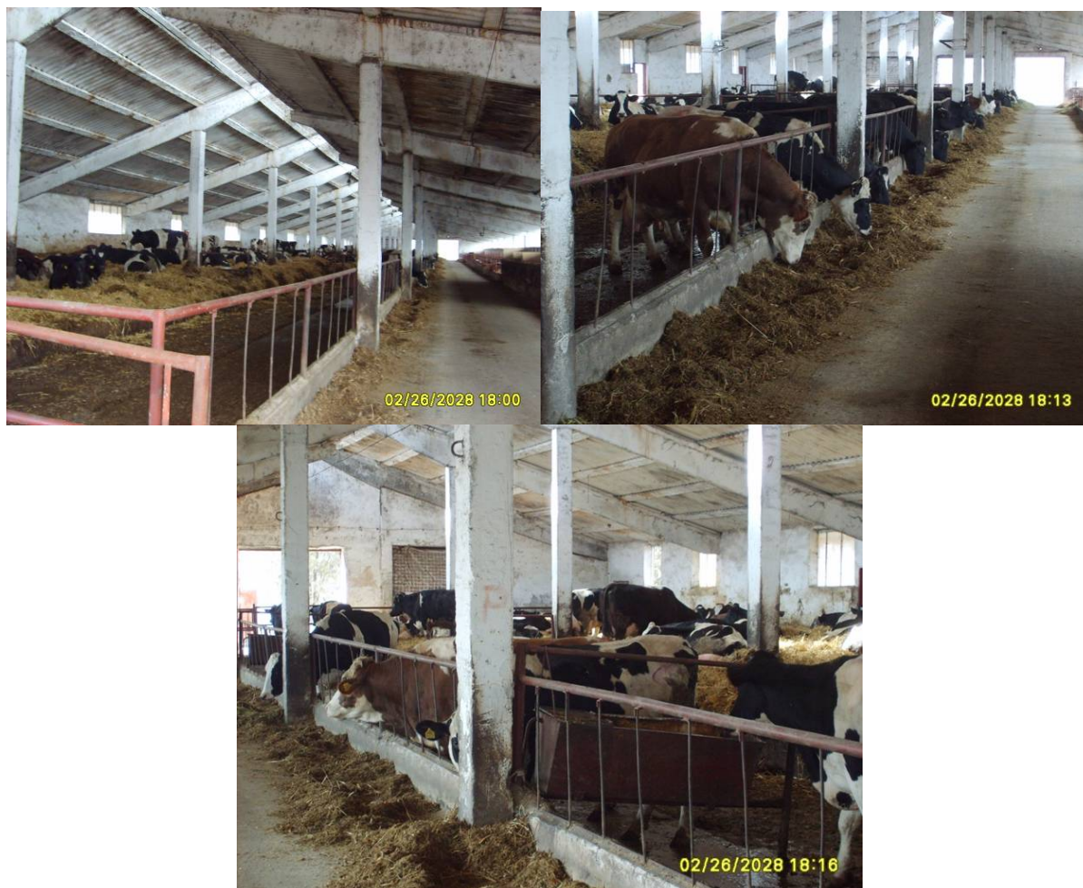
Мал.. 8.5. Конструктивні рішення для безприв'язного утримання
