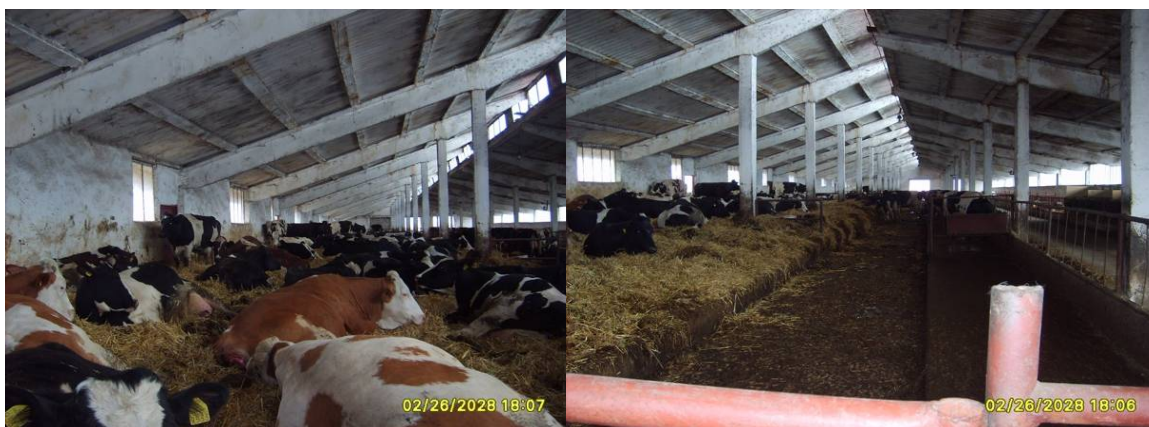
Мал. 8.6. Конструктивні рішення із зоною відпочинку на швидкозношуваній підстилці
